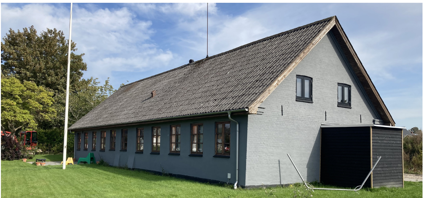
Længehuset ud til Odensevej
