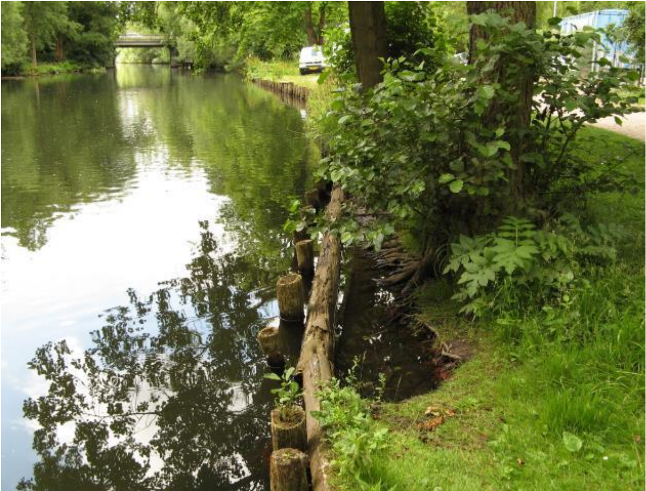
Figur 10: Strækning set fra Munke Mose mod Kastanievej (mod syd/opstrøms).
