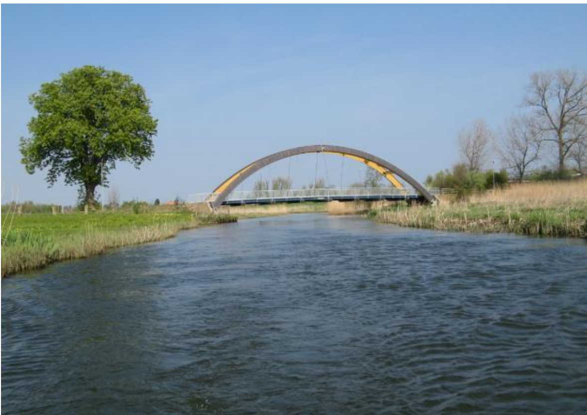
Figur 15: Ved stibroen opstrøms Kertemindevej.
