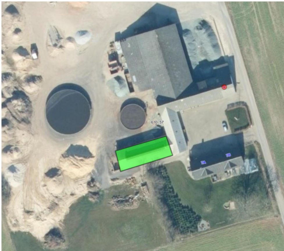
Figur 1. Dyreholdet er placeret i bygningen markeret med grøn.
