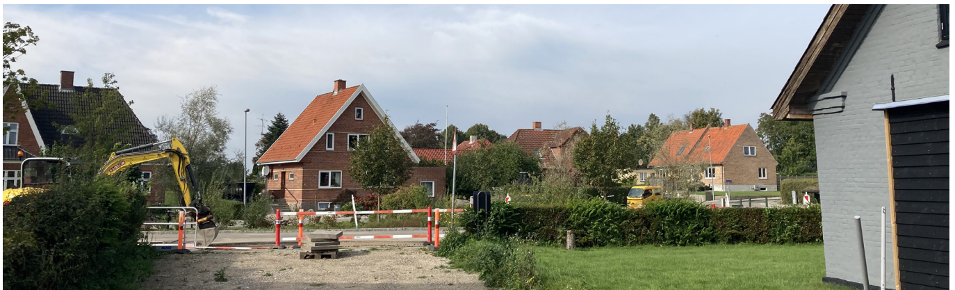
Kig fra lokalplanområdet ud mod Odensevej
