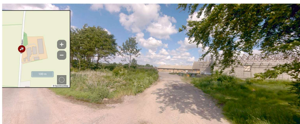
Figur 7: COWI gadefoto (DDG) – Ved indkørsel til landbrugsejendommen Bagmarken 4, 5672 Broby. Gyllebeholder, som overdækkes, kan ses i baggrunden til venstre for de gule driftsbygninger.
