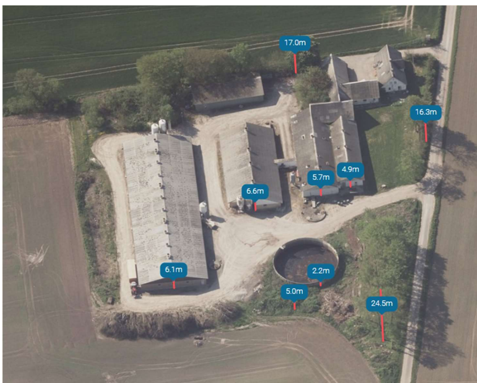
Figur 10: Klimadatastyrelsens skråfoto over ejendommen Bagmarken 4, 5672 Broby med angivelse af nærmeste driftsbygningens højde til kip, højde på gyllebeholder, uden påmonteret teltoverdækning, samt højde af læhegn samt beplantning. Der gøres opmærksom på, at der kan være en vis måleusikkerhed ved disse målinger.
