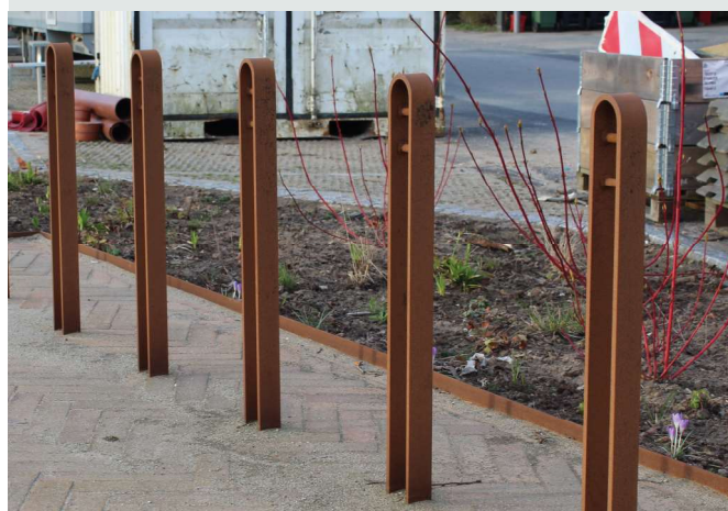
Eksempel på cykelparkering opstillede i torvet i forbindelse med byfornyelse. Farven er cortenstål.
