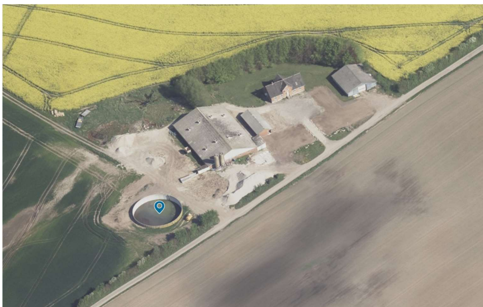
Figur 3: Klimadatastyrelsens skråfoto over landbrugsejendommen Dyndbjergvej 10, 5672 Broby. Gyllebeholderen, tilknyttet landbrugsejendommen på Dyndbjergvej 10, 5672 Broby, er markeret med en blå "knappenål".
