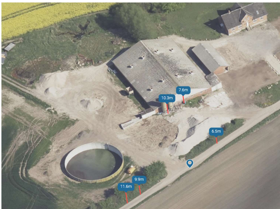
Figur 8: Klimadatastyrelsens skråfoto over ejendommen Dyndbjergvej 10, 5672 Broby med angivelse af nærmeste driftsbygningens højde til kip, højde på siloer samt højde af læhegn. Der gøres opmærksom på, at der kan være en vis måleusikkerhed ved disse målinger.
