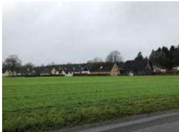
Husene langs Gulfeldtsvej er nogle steder slidte og utidssvarende.
