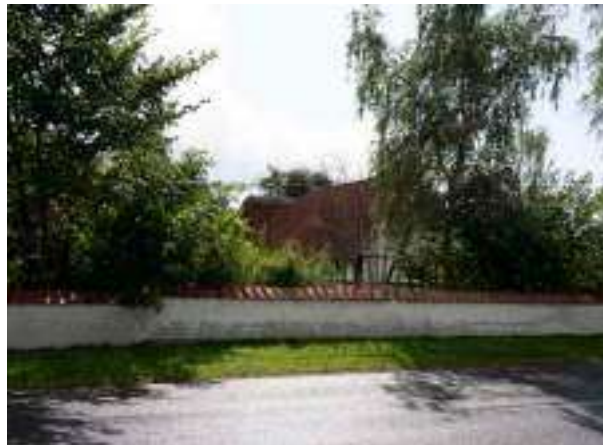
Den korte strækning langs Ståbyvej er misligholdt og virker lukket.
