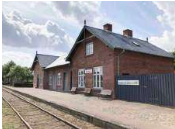
Den gamle stationsbygning er et aktivt center i byen.
