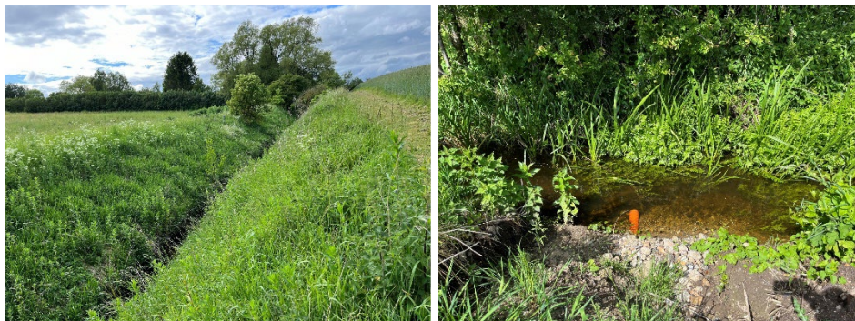
Figur 6-14 Til venstre ses foto af vandløbsstrækning VHS211V, foto er taget i retning mod nordvest. På denne del af vandløbsstrækningen er vandløbet lysåbent og har stejle høje brinker. Til højre ses foto af vandløbsstrækning VHS212V, på foto ses drænrør fra mark, der afvander til vandløbet. Vandløbet har her sten i bunden og flere vandplanter. Mod nord er brinken tilvokset med vedplanter. Brinker er her relativ flade. Foto er taget i retning mod nord i den østlige del af vandløbet.
