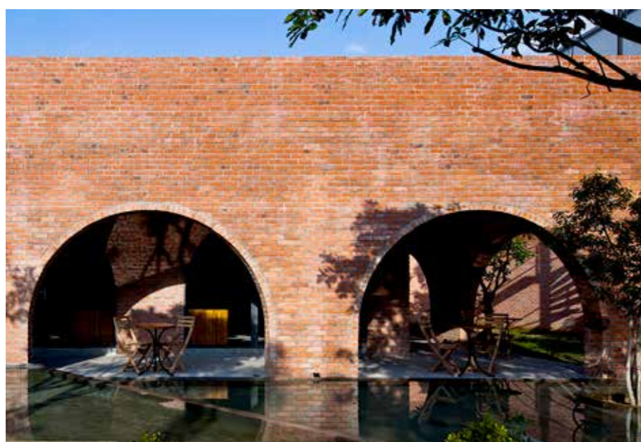
4. Eksempel på møde mellem bygning og Sundrenden
