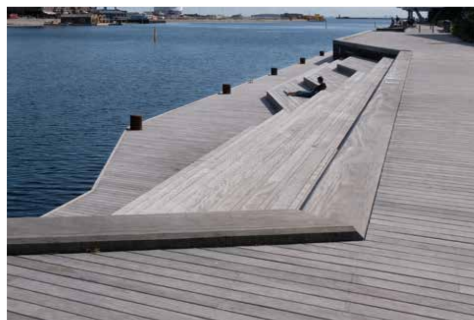
3. Træbryggens nedtræpning giver kontakt til vandet
