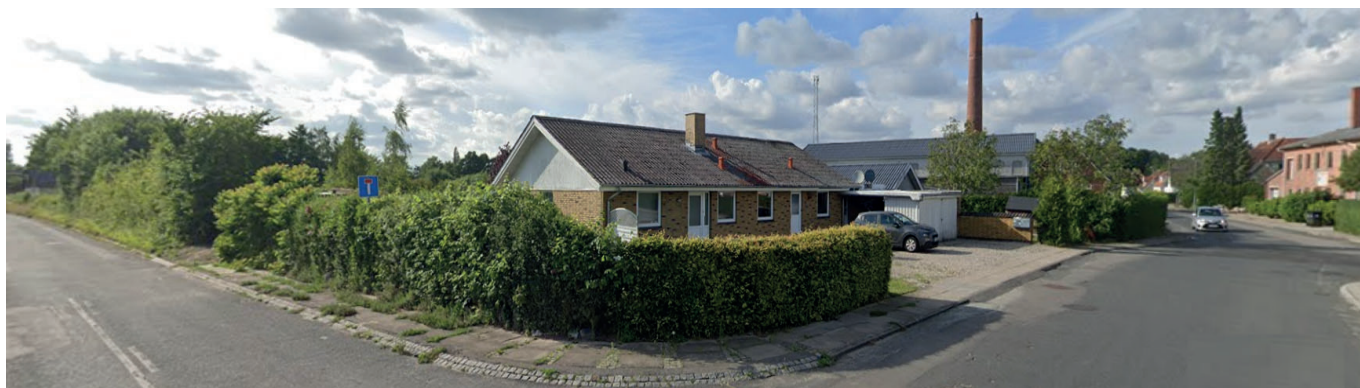
Google Street view - Eksisterende ejendomme, Enghavevej 15A, 15B, 17A og 17B inden for lokalplanområdet.
