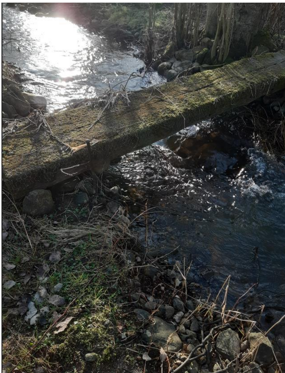
Figur 4: Bro 6 - Bro lavet af træ. Under terræn. Mål: 50x400 cm. Laves om til nyt spang med samme dimensioner, som nr. 1 og 5.
