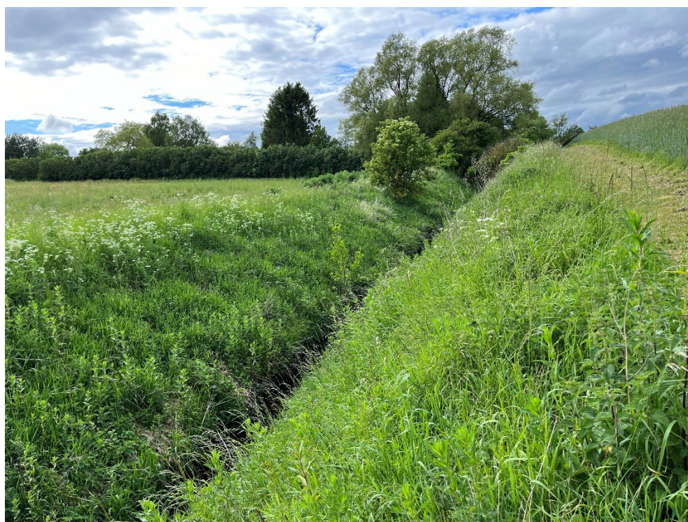
Figur 3-30 Foto af vandløbsstrækning VHS211V, foto er taget i retning mod nordvest. På denne del af vandløbsstrækningen er vandløbet lysåbent og har stejle skråninger.
