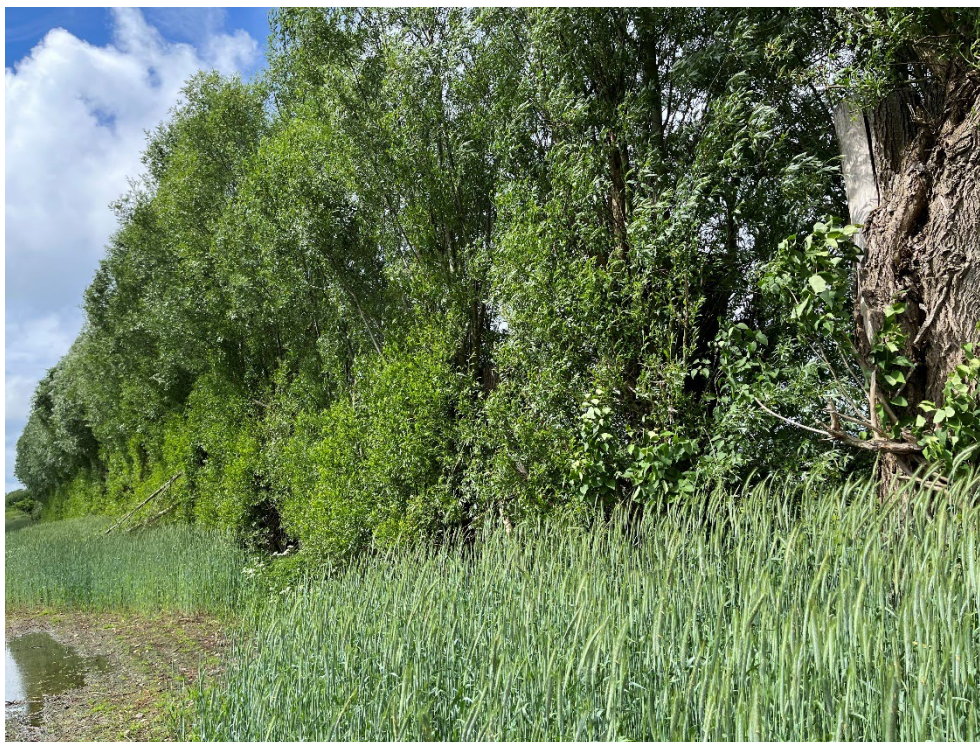
Figur 3-63 Foto af dige VHS223D, hvor det ses at diget er bevokset med store pil. Foto er taget i retning mod nordvest.
