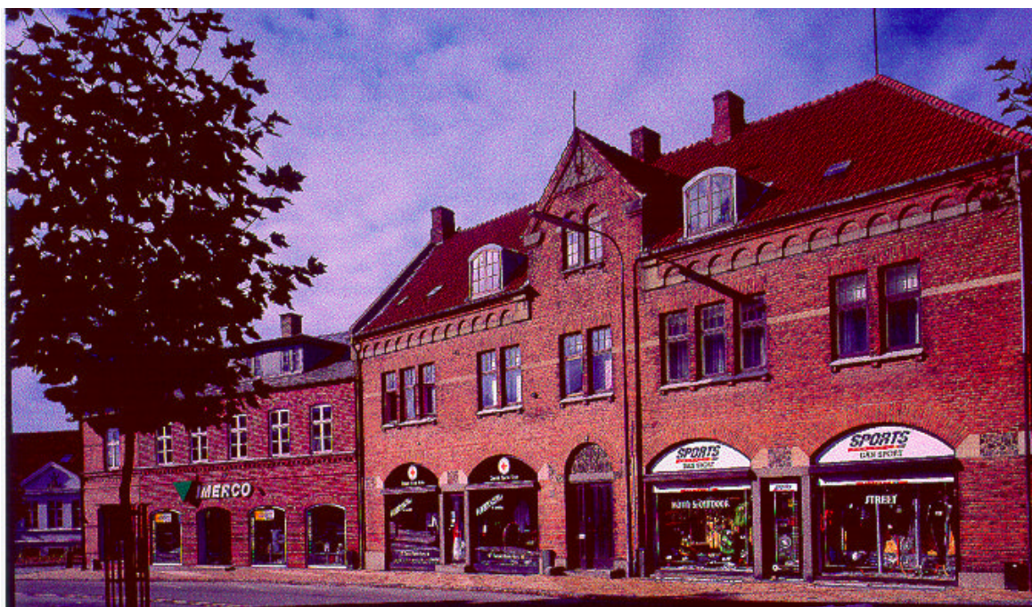
Renovering af facader med stor respekt for de oprindelige huse
