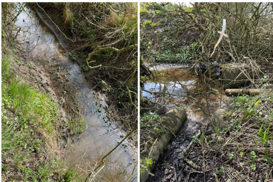
Figur 3-12 S04V. Drænrør der leder vand ud i vandløbet hvor vandløbet slår et 90 grader knæk. Foto er taget hhv. mod øst (tv.) og mod syd (th.).
