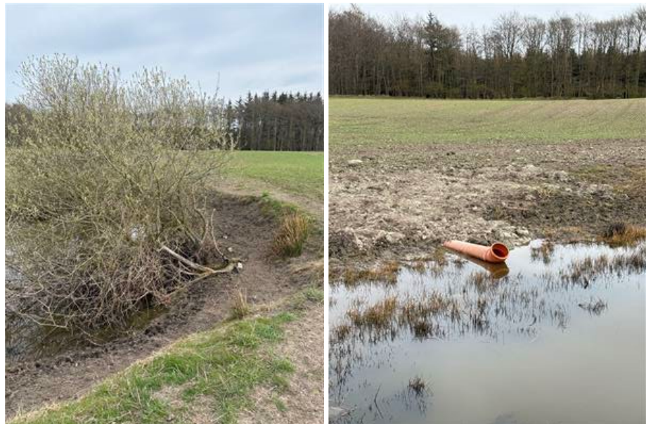
Figur 3-18 Drænrør i nordlig ende og pil i sydlig ende af vandhul.
