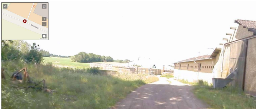
Figur 6: COWI gadefoto (DDG) – Ved indkørsel til Odensevej 19, 5672 Broby.
