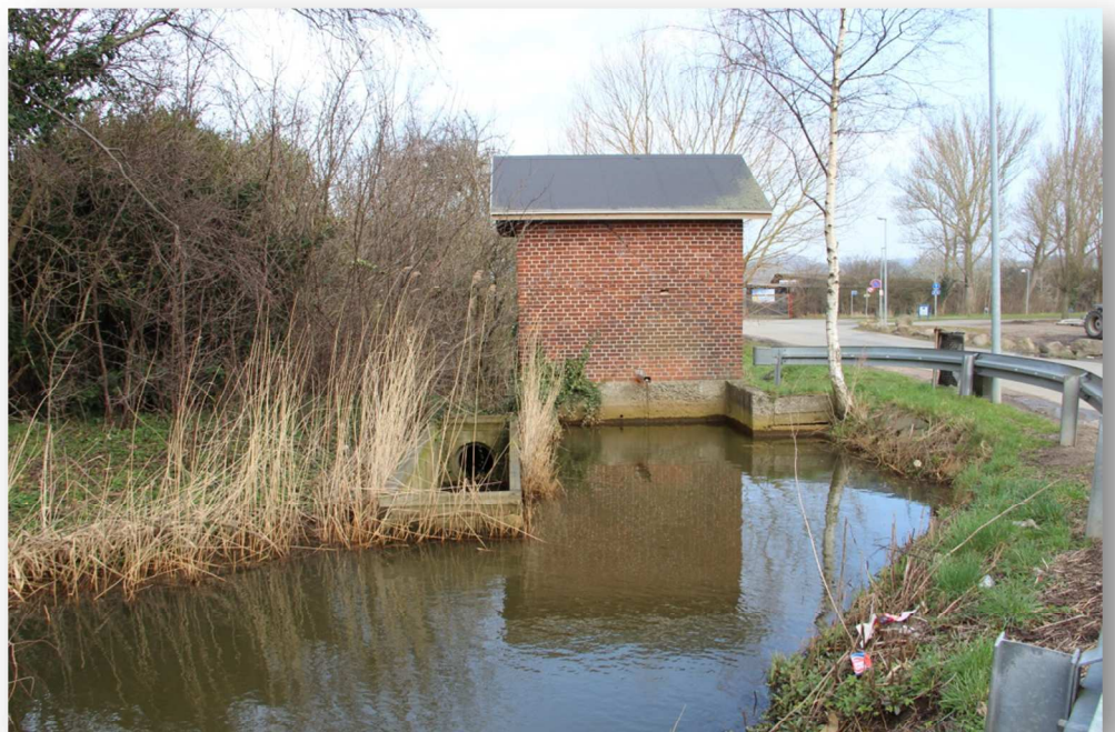
Figur 4 Pumpestation ved Sundrenden (indløb/tilløb)
