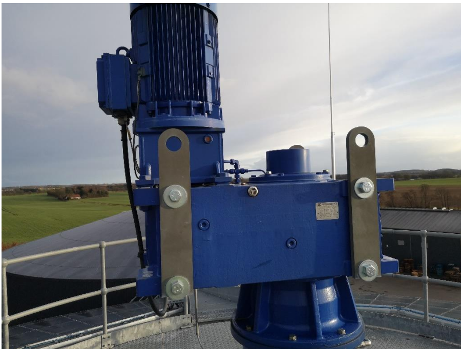
06 Omrører silo- top N. 07 er næ- sten magen til men lidt ældre.
